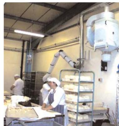
Esempio di FilterBox montato a parete, completo di elettroventilatore, silenziatore e raccordato ad un braccio di aspirazione Proboscide "D".
