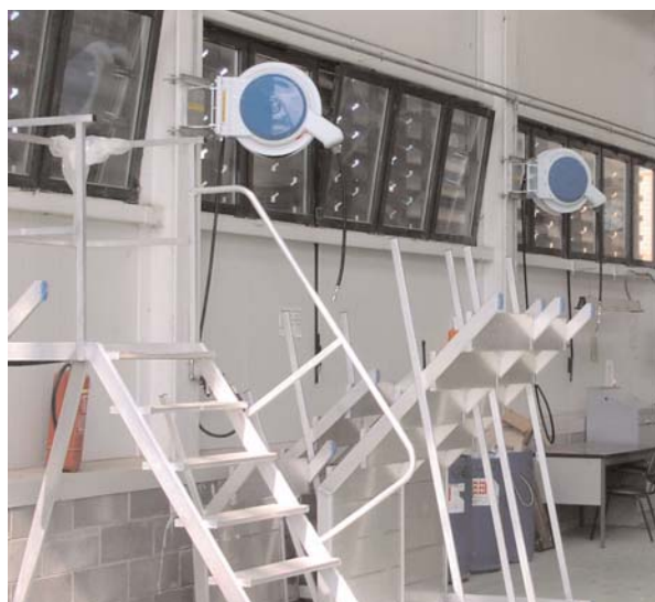
Arrotolatori Serie 884 per la distribuzione di aria e altri tipi di fluidi in un reparto manutenzione.
