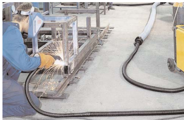
Aspirazione diretta di fumi di saldatura tramite torcia.
