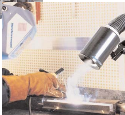
Aspirazione fumi di saldatura con bocchetta.
