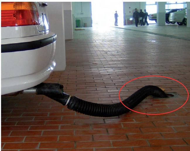
In entrambi i sistemi occorre prevedere una camera di drenaggio al fine di raccogliere il liquido di condensa ed eventuale acqua dal pavimento.
