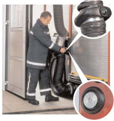
La piastra di ancoraggio è il punto di attacco del sistema di aspirazione al veicolo. Si fissa alla carrozzeria ad un'altezza utile in modo da consentire l'attacco della bocca di aspirazione in modo agevole. L'elettromagnete, completo di maniglia ergonomica, si attacca istantaneamente alla piastra di ancoraggio.
